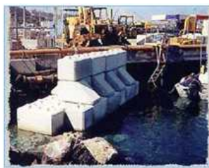
해안 구조물 공사
